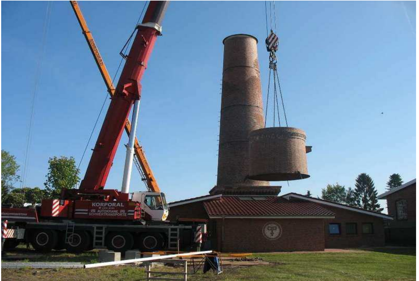
Die tonnenschwere Krone schwebt Meter für Meter der Turmspitze entgegen. Fotos: Susanne Risius-Hartwig
