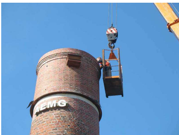
Die tonnenschwere Krone schwebt Meter für Meter der Turmspitze entgegen. Fotos: Susanne Risius-Hartwig
